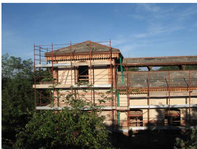
Edificio della ferrovia storica Barge –Bricherasio in ristrutturazione per la creazione di un Centro polifunzionale
